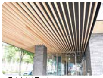
▲県産木材を用いたエントランス
