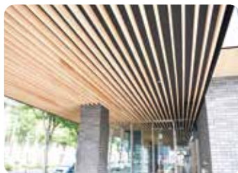
▲県産木材を用いたエントランス
